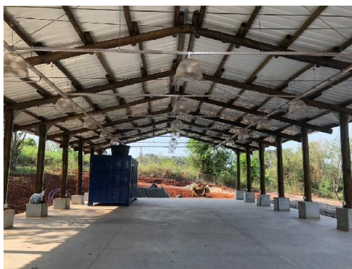
Figura 78: Central de compostagem (em instalação)
