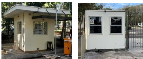
Figura 59: Guarita do Portão de Ferro e a da Carlos Botelho.
