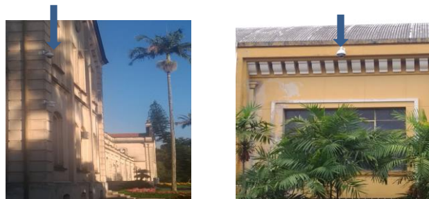
Figura 5: Novo monitoramento por câmeras
