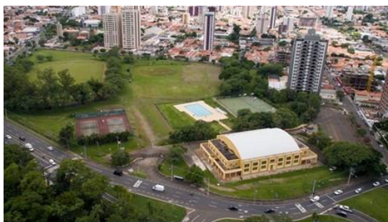
Figura 16: Vista Geral da SCPRAES
